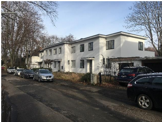
1 - Paul-Finger-Straße 4-10, 1930/31 Arbeitsgemeinschaft der Architekten
