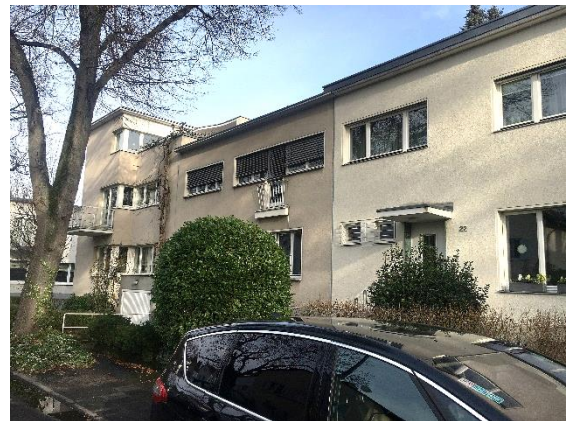
2 - Paul-Finger-Straße 18-24, 1931 Arbeitsgemeinschaft der Architekten
